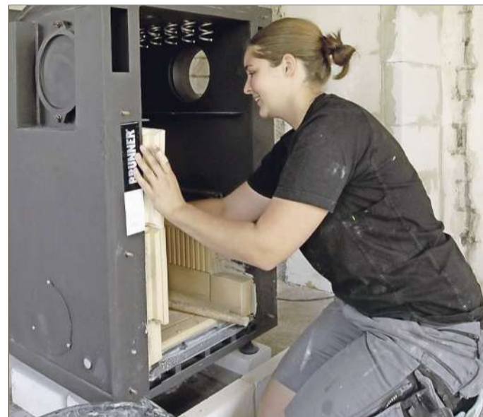
Maren Schulz beim Einbau einer neuen Anlage.
